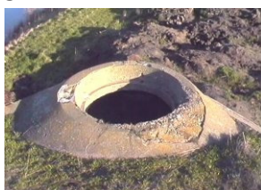
Kijkgat aan de bovenkant van de bunker
